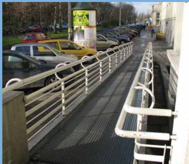
Podjazd do domu studenckiego UJ „Nawojka”
