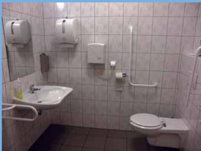
Toaleta w domu studenckim AP „Za kolumnami”
